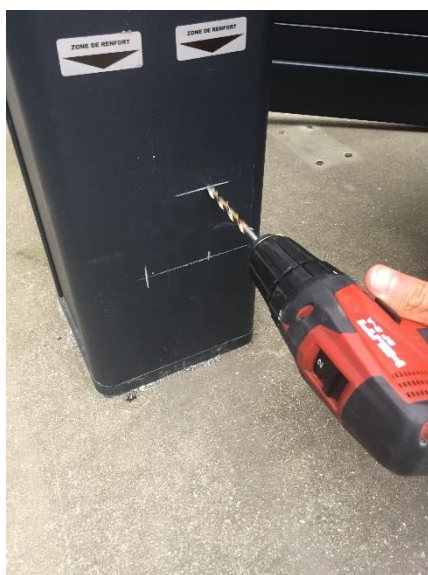
Perçage Ø 6,5mm
